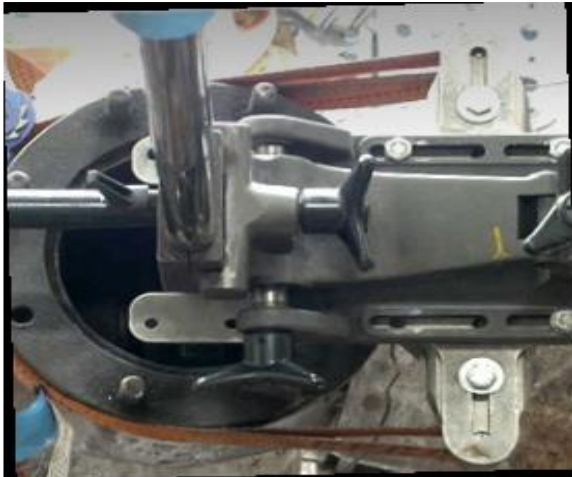
대구 열병합발전소, 1500 # 8 "Gate Valve Seat Lapping SL-2 작업모습
